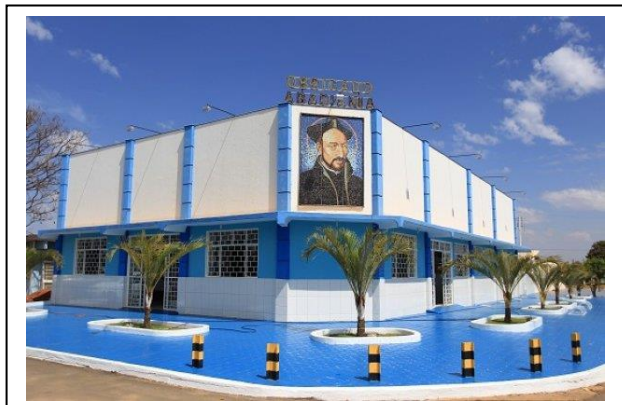
FACHADA DA CASA DOM INÁCIO
