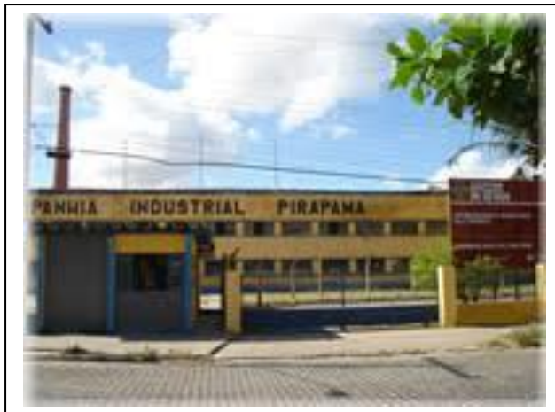
FACHADA DA FÁBRICA PIRAPAMA – ESCADA.
