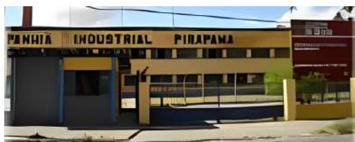
FACHADA DA FÁBRICA PIRAPAMA - ESCADA.
